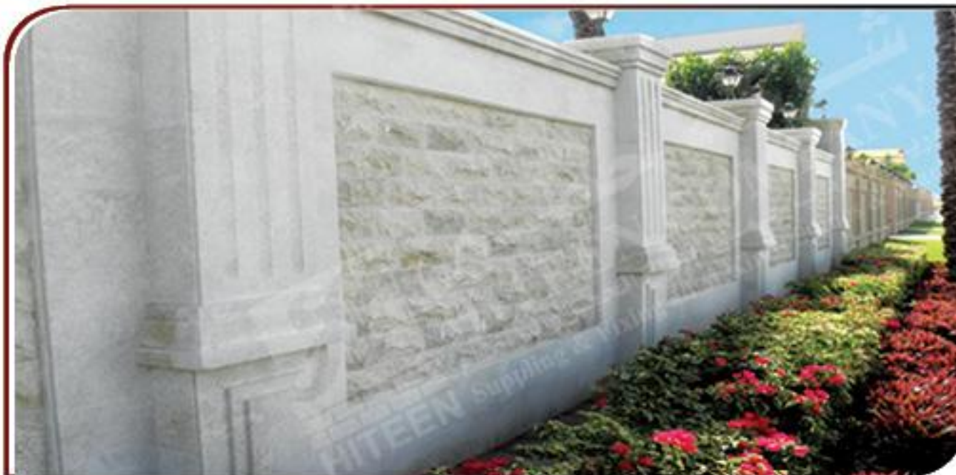
حجر أردني معان "ممسوح وطيزة" للمساحات المفتوحة و أردني معان ممسوح للديكورات - ( دبي - الخوانيج )
