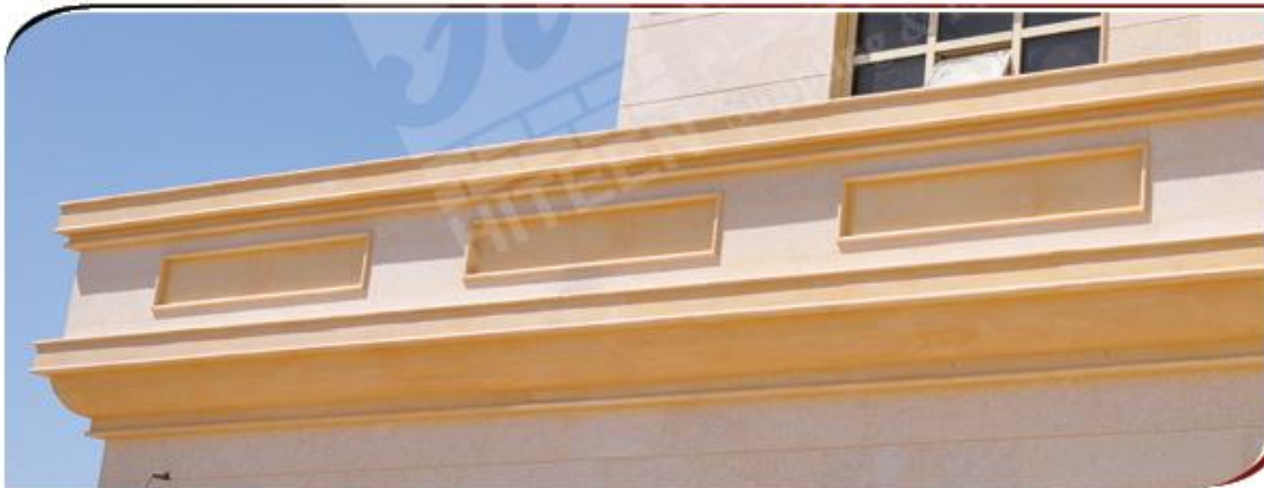
Palastinian Stone polish Cream for flat area & Saudi cream for decorations. ( Dubai - Al Khwaneej) حجر فلسطيني كريمي مجلي للمساحات المقتوحة وسعودي كريمي للديكورات ( دبي - الخوانيج )
