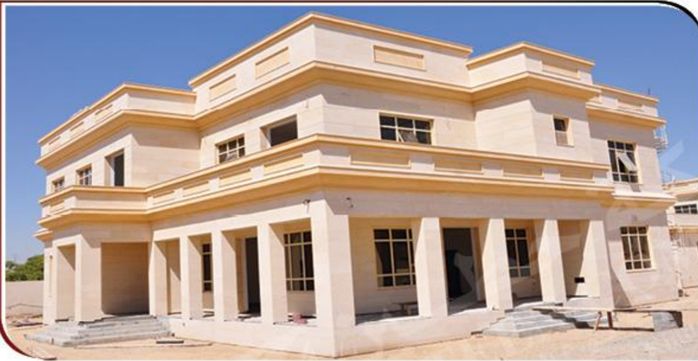
Palastinian Stone polish Cream for flat area & Saudi cream for decorations. ( Dubai - Al Khwaneej) حجر فلسطيني كريمي مجلي للمساحات المقتوحة وسعودي كريمي للديكورات ( دبي - الخوانيج )
